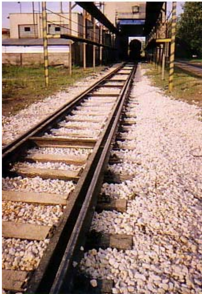
Stav po rekonštrukcii a sanácii.
